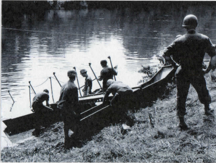
Aufbau einer Fußgängerbrücke nach Kisselwörth durch amerikanische Pioniere
